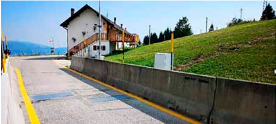
Foto 2 – Particolare delle piastre di rilevamento peso (Minati, 2020).
