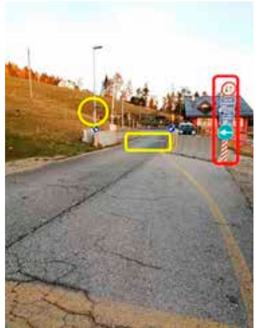
Foto 1 – Pesa dinamica (località Tombal, Comune di Enego VI) - in giallo la telecamera di inquadramento targhe e le piastre per il rilevamento del peso. In rosso, la segnaletica stradale per le indicazioni sulla procedura di attraversamento del varco (Minati, 2020).
