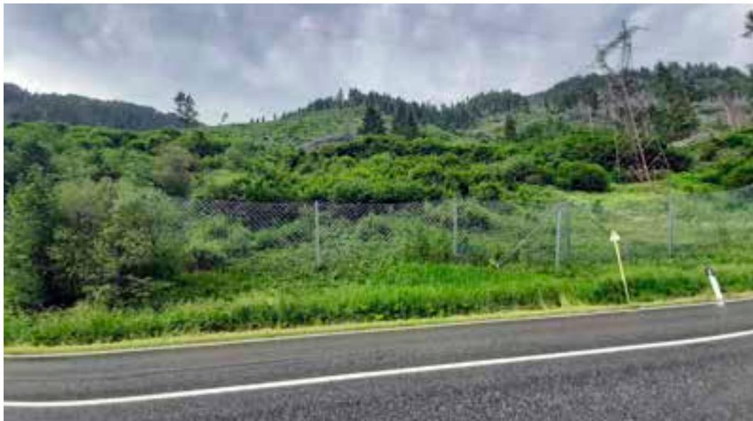
*Figura 6 – Predazzo, loc. Mezzavalle – Opere paramassi in fregio alla strada. Nell'eventualità di valanghe (poco probabili) le protezioni dai massi sono poco efficaci, a differenza del vallotomo che può assolvere entrambe le funzioni. Anche l'aspetto paesaggistico è diverso.*
