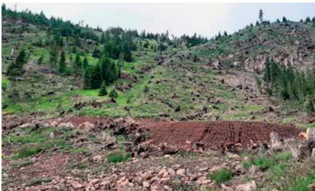
Figura 3 – Ville di Fiemme, Passo Lavazè – Tomo paravalanghe a protezione della strada statale. In primo piano la piazzola terminale di una strada forestale realizzata per il recupero del legname. L'orografia, la presenza di rinnovazione naturale, di cepaie di grosse dimensioni e della strada sarebbero di per sé sufficienti a rendere sicuro il pendio.
