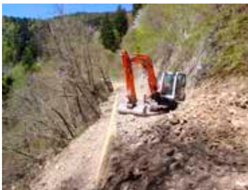
Foto 1 – Trasformazione di coltura infrastrutturale in fase di realizzazione.
