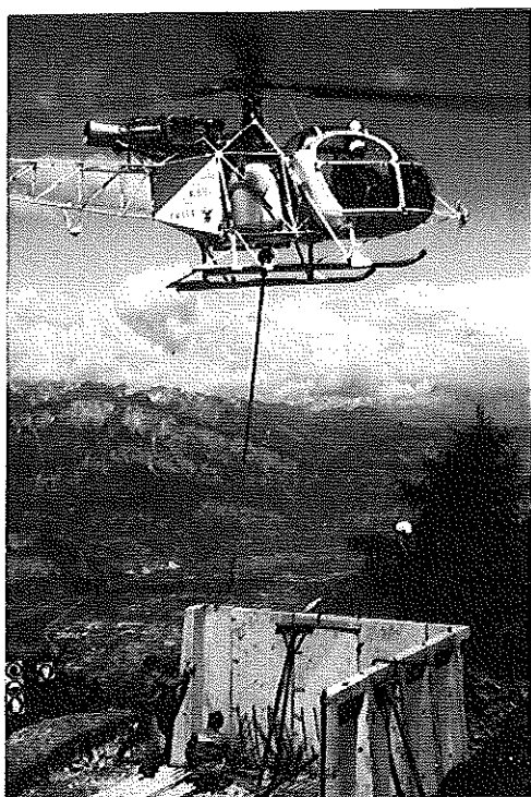
Figura 1 - Il serbatoio d'acqua prefabbricato viene direttamente e rapidamente assemblato anche con elicottero.
