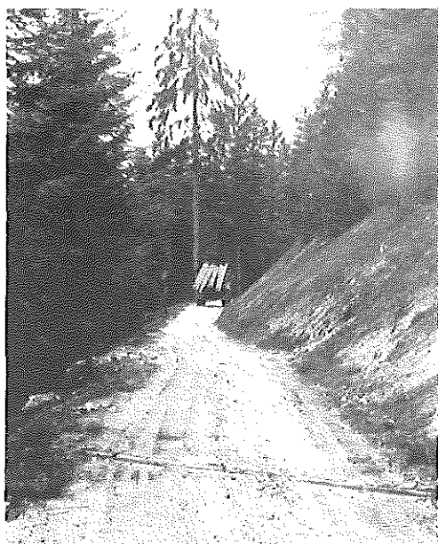
Strada forestale «Cercenadura Fratte» - Tonadico - Primiero
