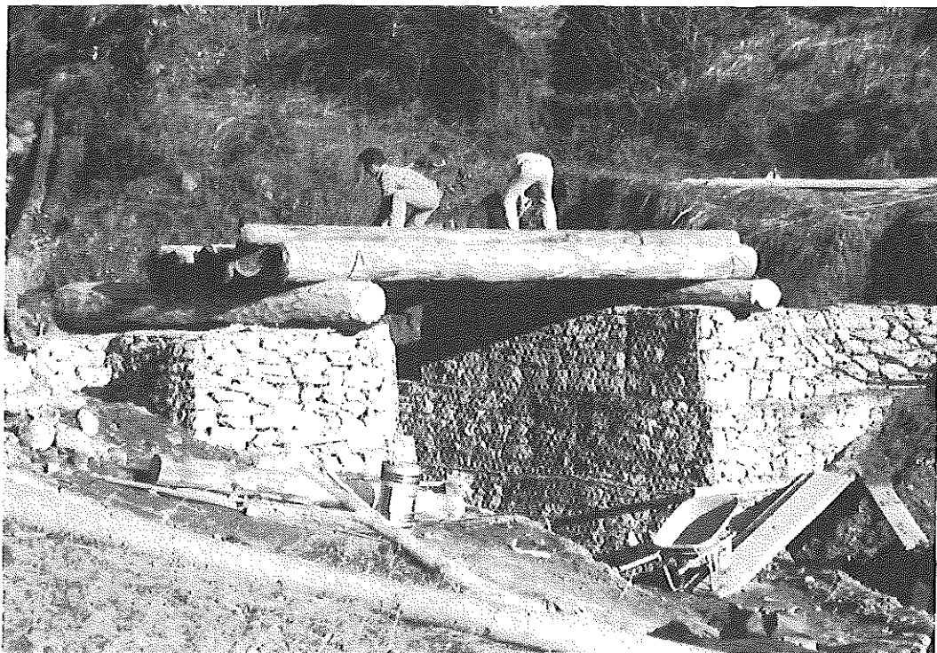
Costruzione di ponte in tronchi su spalle in gabbioni - Strada forestale «Camo» - Fiera di Primiero.
