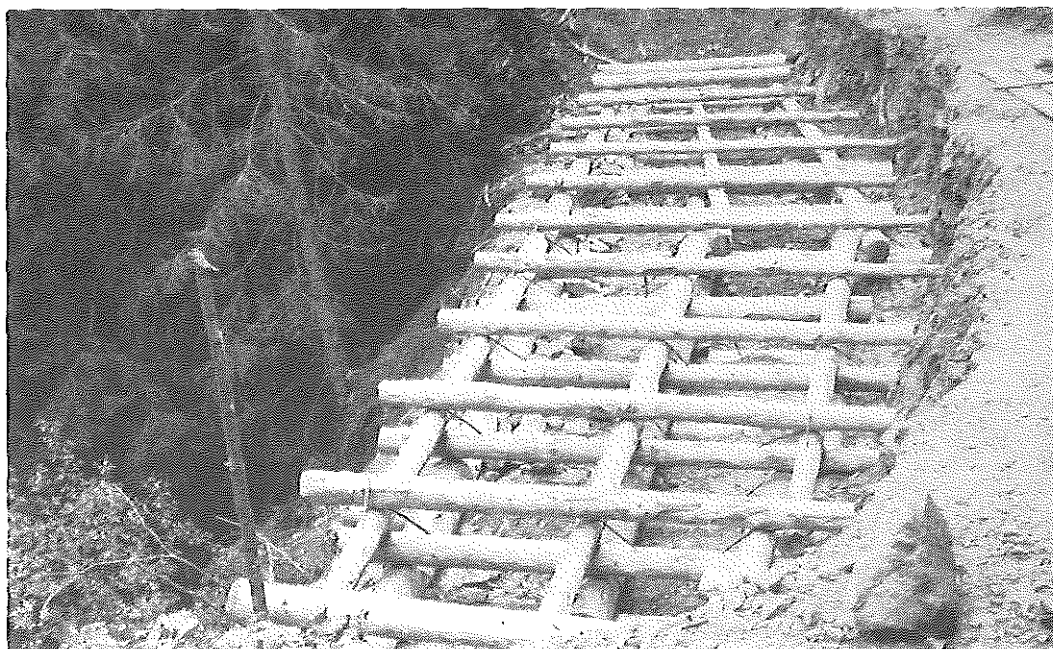
Costruzione di «arcia» in legno - Strada forestale «Del Fen» - Canal S. Bovo - Vanoi.
