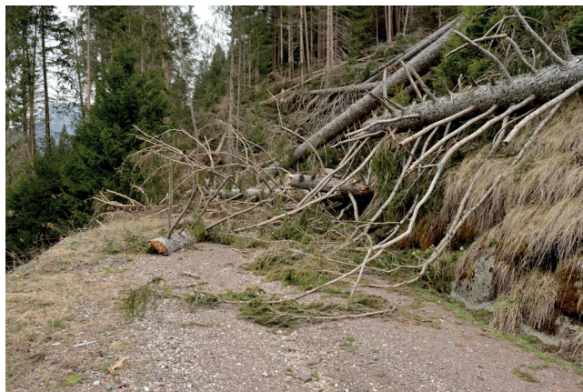
Foto 1 - Schianti su strada forestale
