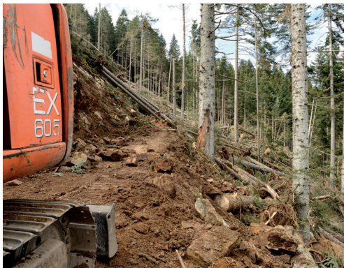
Foto 9 - Ripristino viabilità forestale
