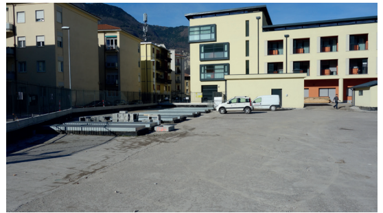
Foto 2 - Il parco prima dei lavori
