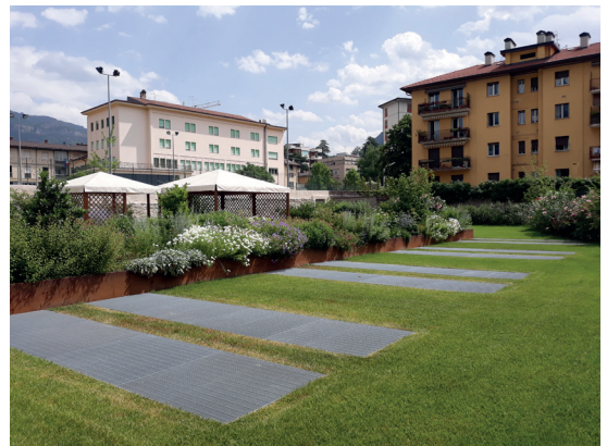
Foto 3 - Il parco dopo i lavori
