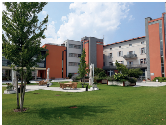
Foto 7 - La piazza dopo i lavori
