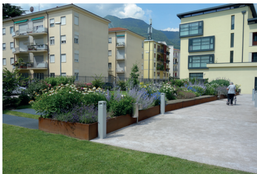
Foto 4 - Il parco dopo i lavori
