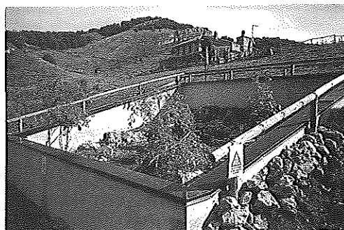
Fig. 3- Foto della struttura.
