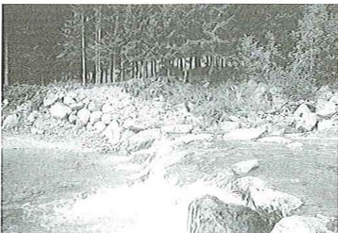
Fig. 7 - Briglia in massi cementati realizzata sul torrente Maso di Spinelle.
