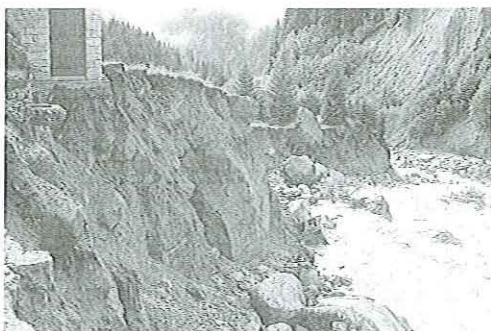
Fig. 4 - Torrente Maso di Spinelle: approfondimenti dell'alveo ed erosioni di sponda verificatesi a seguito dell'evento alluvionale del 2 Ottobre 1993 in corrispondenza del tratto successivamente sistemato con un selciato in massi legati.
