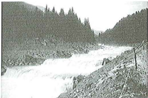
Fig. 9 - Tratto del torrente Maso di Spinelle sistemato con briglie in massi cementati: fotografia scattata durante l'evento di piena del 14-18 Ottobre 1996.
