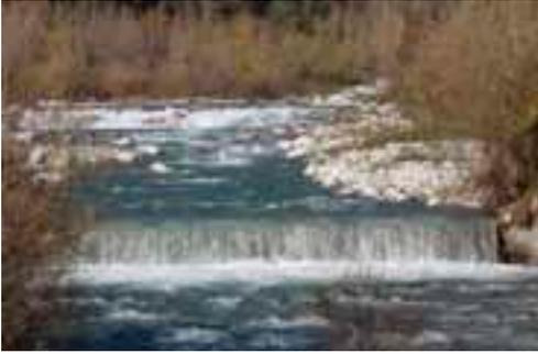
Fig. 8 – Briglia trasformata in rapida artificiale, sul Torrente Maso a Carzano. Prima dell'intervento, la briglia era simile a quella visibile in primo piano.
