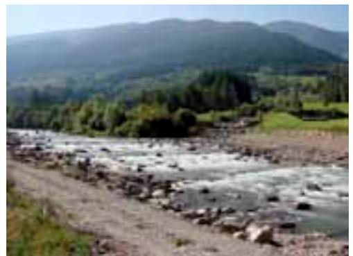
Fig. 3 – Briglia trasformata in rapida artificiale, sul Torrente Avisio a Tesero.
