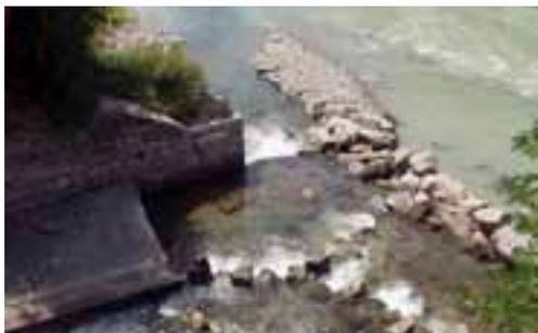
Fig. 5 – Scalinata di briglie trasformata in successione di vasche, sul Torrente Fersina a Trento.
