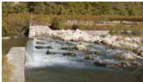
Fig. 7 – Briglia resa transitabile per i pesci con massi ciclopici bloccati in rapida artificiale, sul Fiume Noce a Mezzolombardo.
