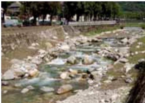
Fig. 4 – Briglia trasformata in rapida artificiale, sul Torrente Cismon a Fiera di Primiero.
