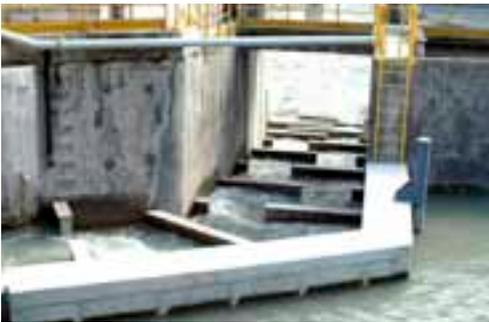
Fig. 10 – Scala di monta sul Fiume Adige, presso lo sbarramento di Ala.
