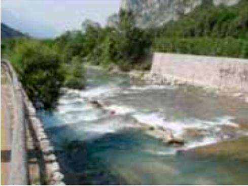
Fig. 1 – Briglia dotata di successione di vasche realizzate in massi, sul Fiume Sarca a Ceniga.
