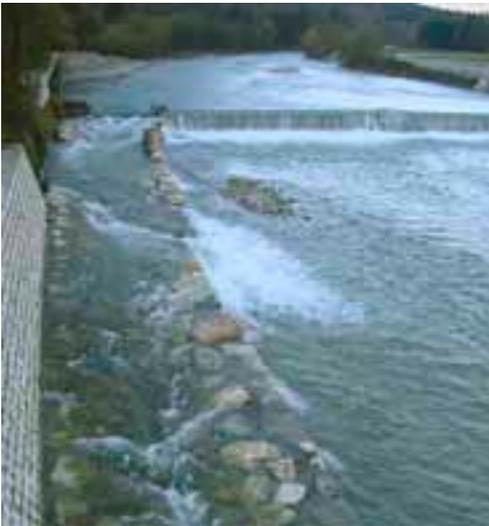
Fig. 9 – Rampa in massi bloccati alla base, sul Fiume Brenta a Ospedaletto.
