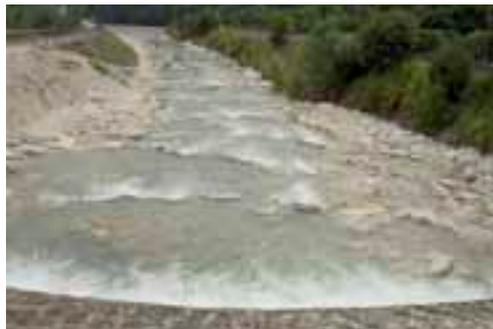
Fig. 6 – Briglia mascherata da cordone di massi bloccati alla base, a formare una rapida artificiale, sul Torrente Leno a Rovereto.
