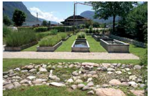
Fig. 4 - Le vasche in cemento
