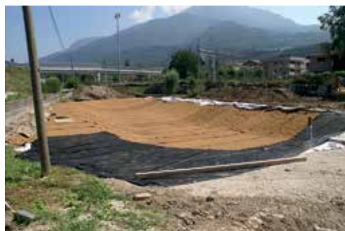
Fig. 2 Impermeabilizzazione del laghetto
