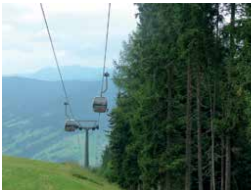
Figura 18: impianto di risalita decorrente lungo il margine del bosco. In queste condizioni la vicinanza della fune alle chiome degli alberi ne diminuisce la visibilità da parte degli animali che dal bosco si dirigono verso lo spazio aperto.
