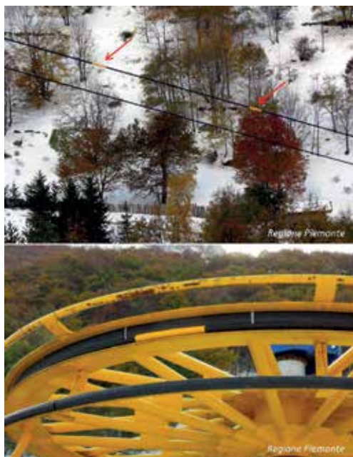
Figura 14: dispositivo di segnalazione consistente in manicotto in PVC di colore giallo avvolto attorno alla fune, in fase di sperimentazione da parte della Regione Piemonte.
