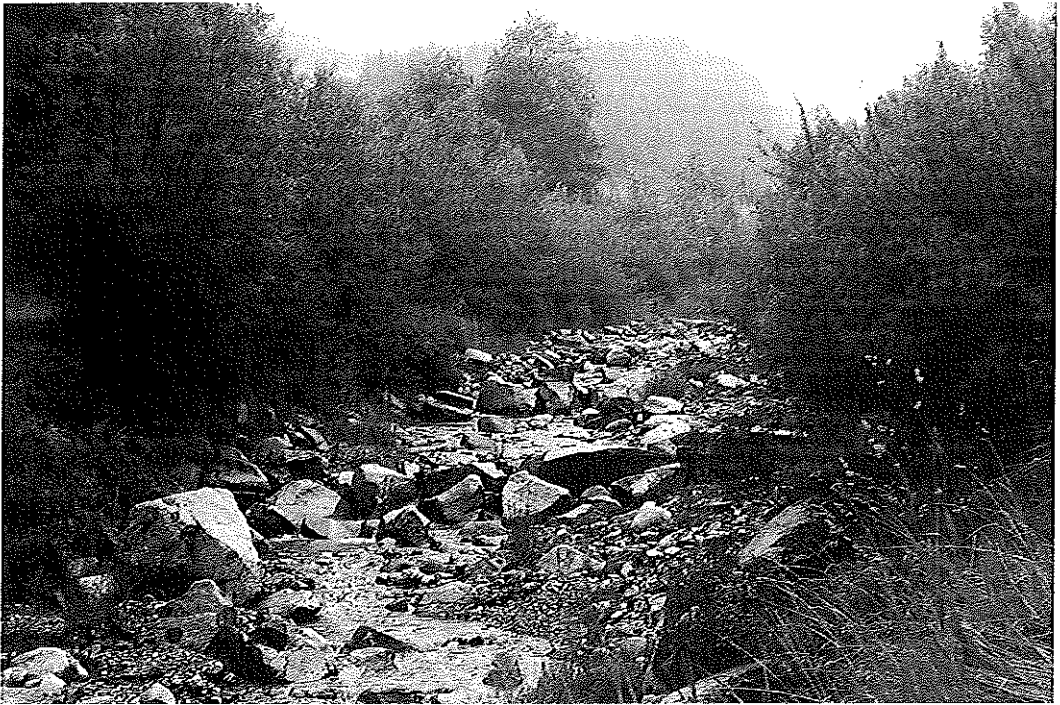
Foto 2 - Un tratto di copertura diffusa realizzata sul Torrente Adanà (Trentino occidentale).
