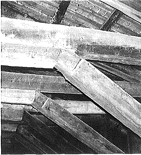
Fig. 6 - Ricostruzione della saetta con pezzi di recupero. Si noti anche l'incalmo della controcatena.
