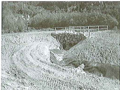
Fig. 6 - Scala di rimonta: particolare delle modalità costruttive.
