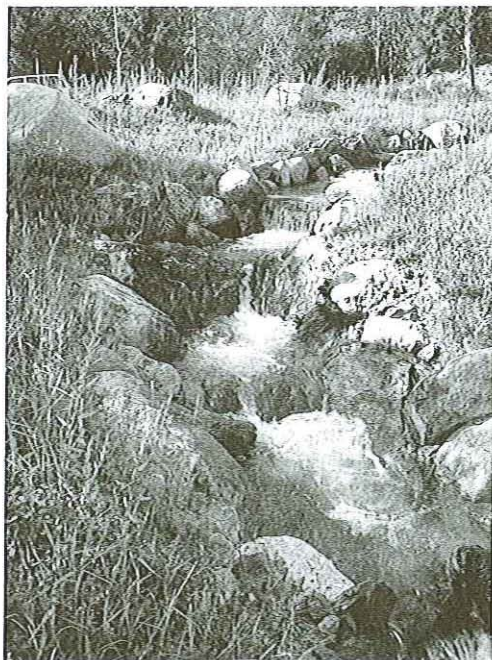
Fig. 8 - Scala di rimonta a lavori conclusi.
