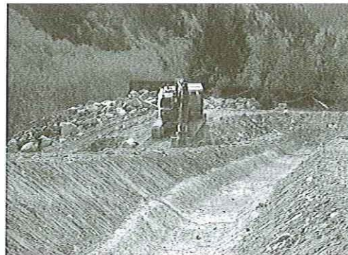
Fig. 7 - Scala di rimonta: particolare delle modalità costruttive.
