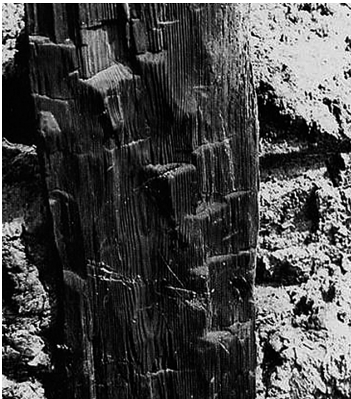
Figura 2 - Particolare del palo squadrato e lavorato su tutta la superficie
